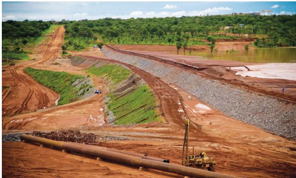
Figura 27: Proteção dos taludes da bacia de rejeitados da SMC. Fonte: Coqueia (2015)
